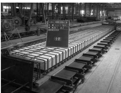
写真-1 鉄筋組立完了
