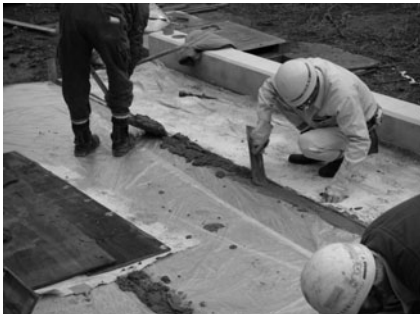
写真-7 間詰めモルタル打設
