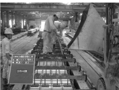
写真-3 コンクリート打設
