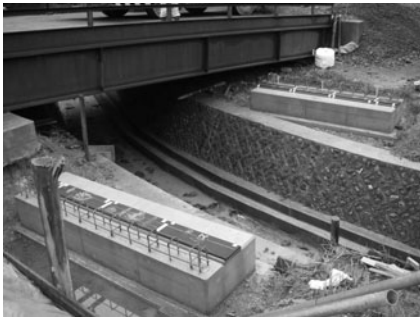
写真-5 架設前状況
