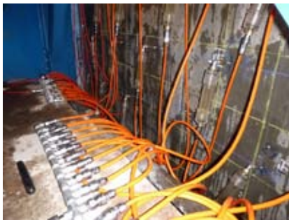
リハビリカプセル工法施工状況
