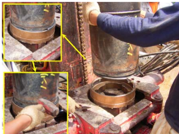
リングロストビットはめ込み状況
