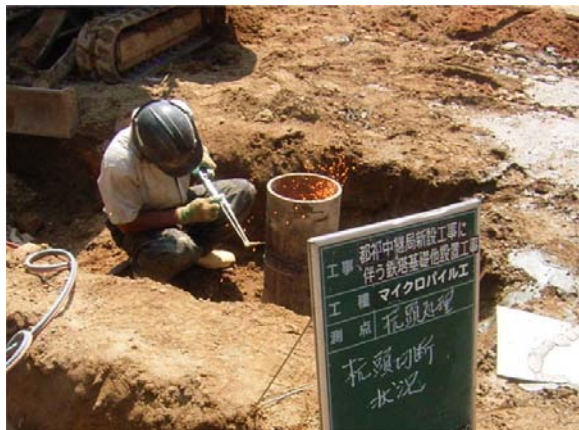
上杭鋼管天端切断状況
