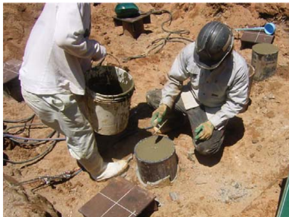
グラウト充填および天端仕上げ状況
