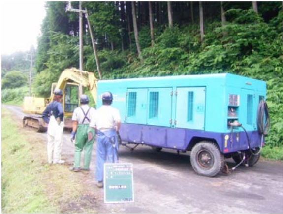
高圧コンプレッサー搬入状況
