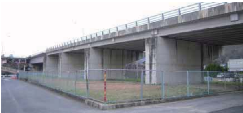
工事着手前現場全景
