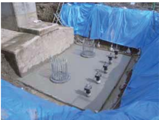
完成 (P8増設部)
