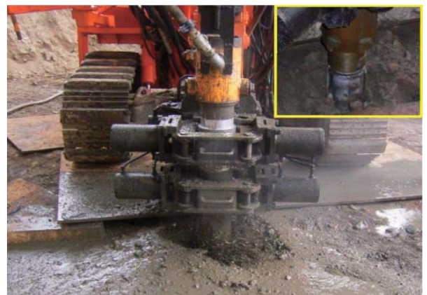
ダウンザホールハンマ削孔状況
