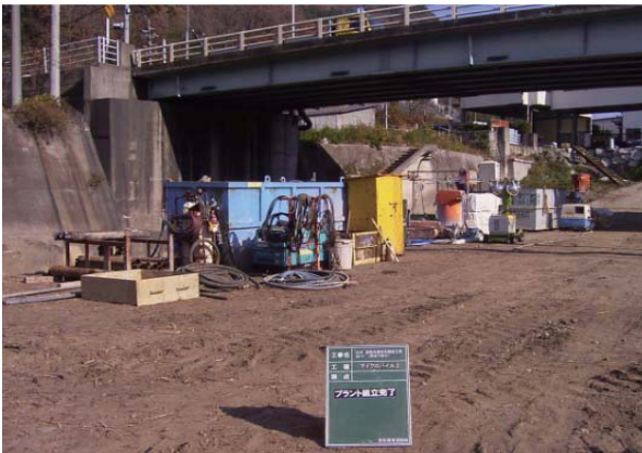
プラント設備
