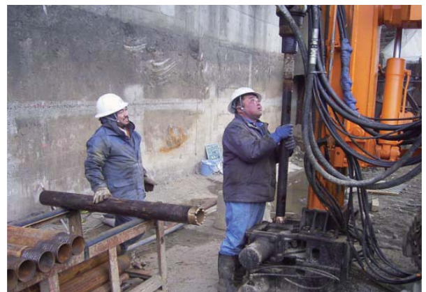
小口径インナー先行削孔状況
