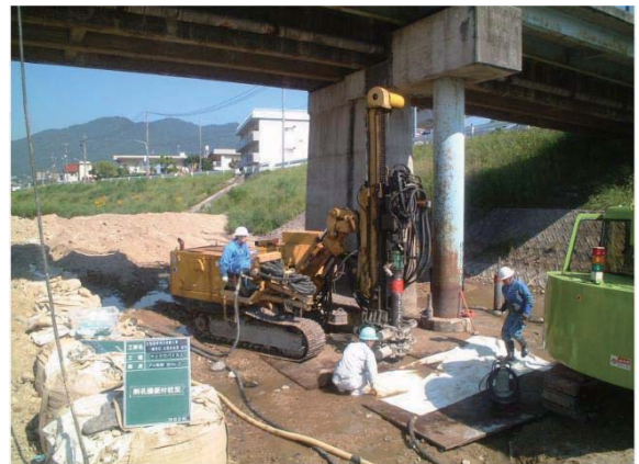
削孔機設置
