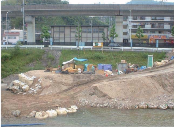
プラント設備
