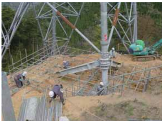
足場組立 (単管足場)
