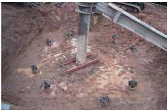
杭打設完了全景
