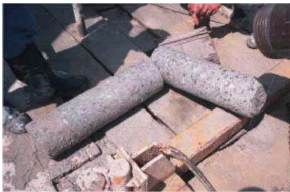
既設コンクリートコア
