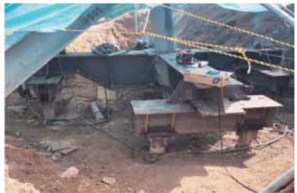
鋼製部材接続
