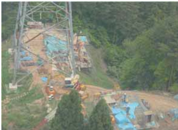
現場全景 (足場・プラント)
