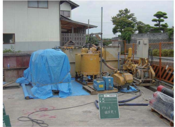
プラント設備
