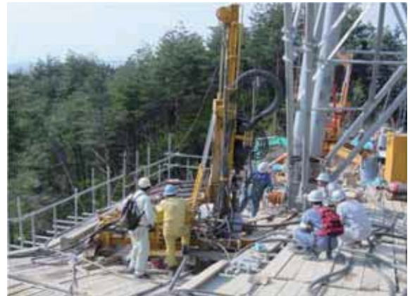
施工状況 (スキッドタイプ)
