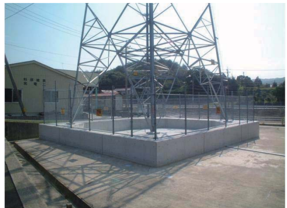
フーチング完成(全景)
