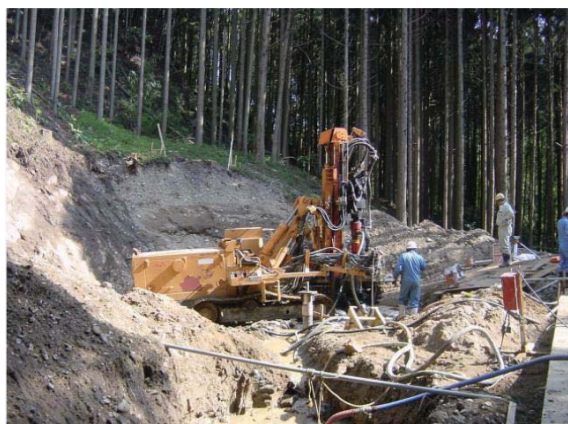
施工状況(全景)
