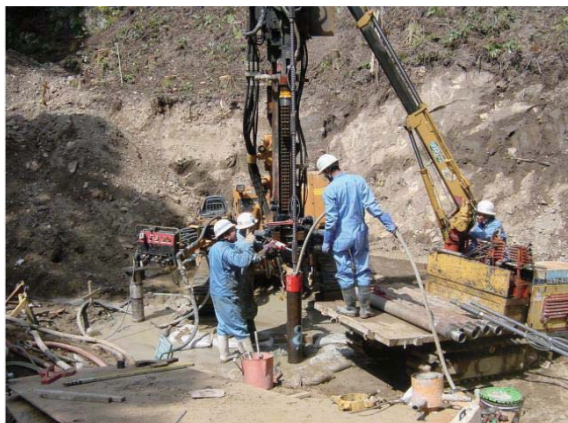
芯鉄筋挿入状況
