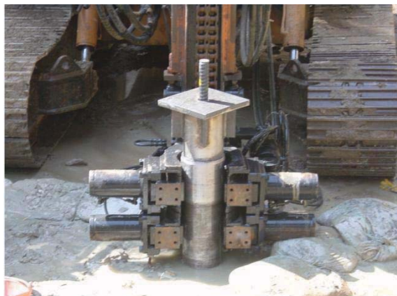
杭頭処理状況
