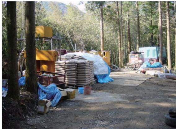
プラント設備
