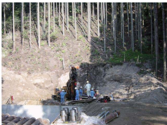
施工状況(全景)
