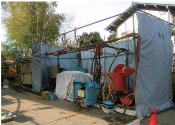
プラント設備
