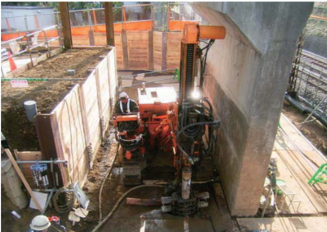
P2側施工状況
