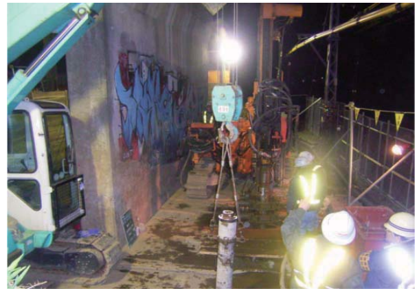
A1(線路)側施工状況
