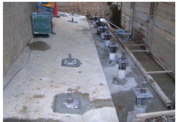
P2側完成全景
