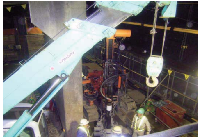
A1(線路)側施工状況
