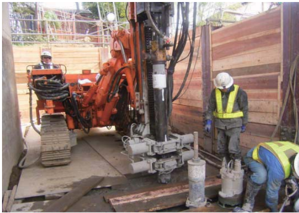
P2側施工状況
