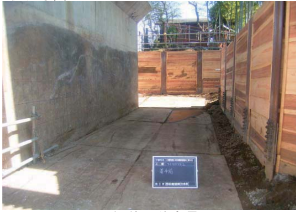
P2側着工前全景
