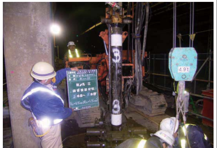
A1(線路)側施工状況
