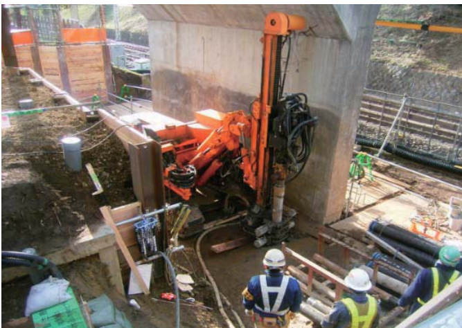
P2側施工状況
