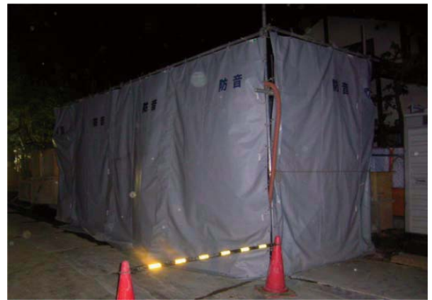
防音対策(プラント部)
