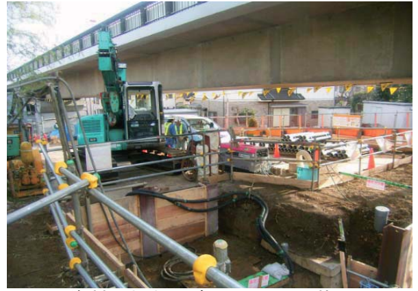
資材置場およびクレーン配置状況
