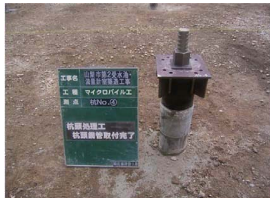
杭頭処理完了
