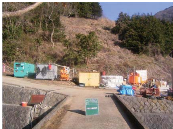
プラント設備
