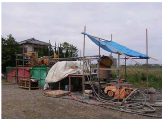
プラント設備
