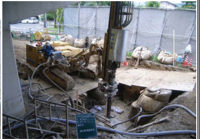
P0施工状況
