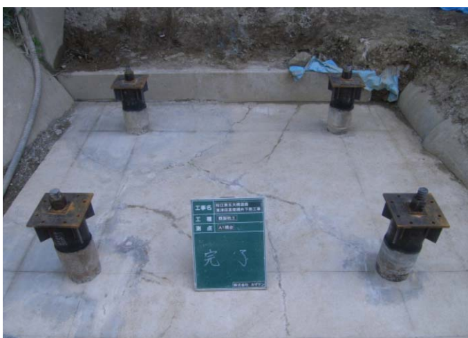
A1完成全景
