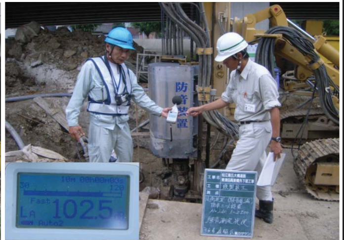
騒音レベル測定(削孔機直近)
