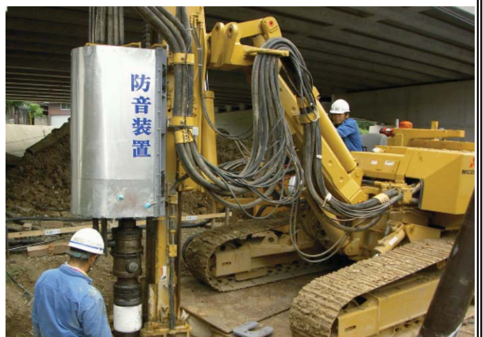
防音装置取付状況
