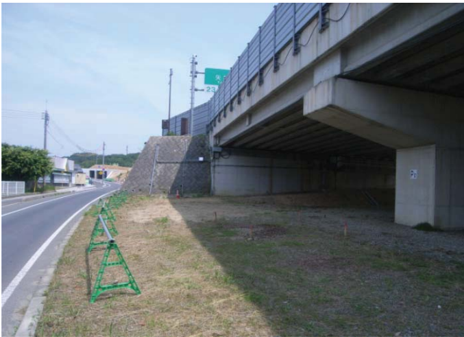
着手前現場全景
