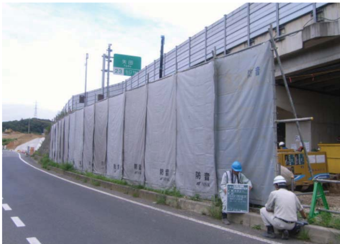
防音シート設置状況
