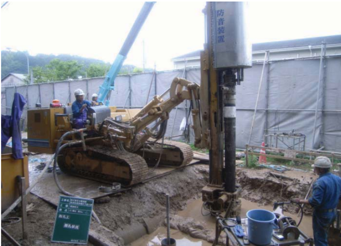
A1施工状況
