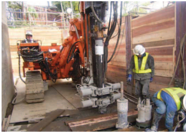
P2側施工状況
