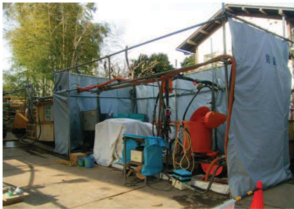
プラント設備
