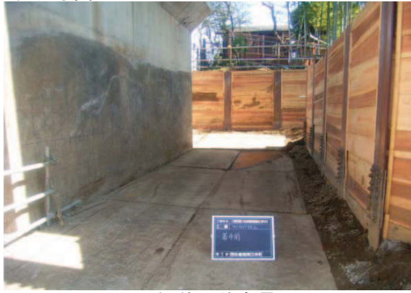
P2側着工前全景
