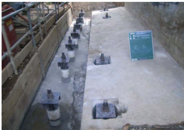
A1(線路)側完成全景
