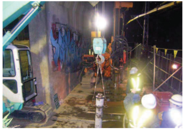
A1(線路)側施工状況
