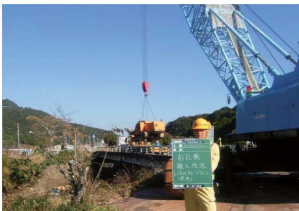
削孔機搬入状況(120t吊クレーン)
