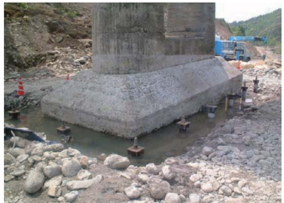
完成全景(下流→上流)
