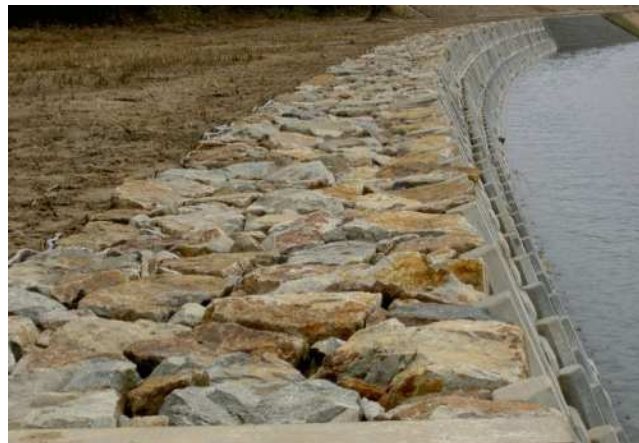
写真-4 自然石を敷き詰めた天端事例
