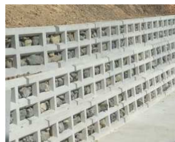
写真-3 前石材設置状況
