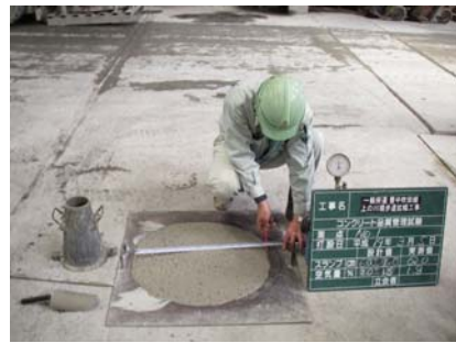
コンクリートの品質管理
