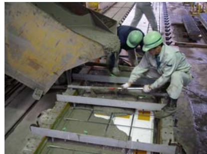
コンクリート打設
