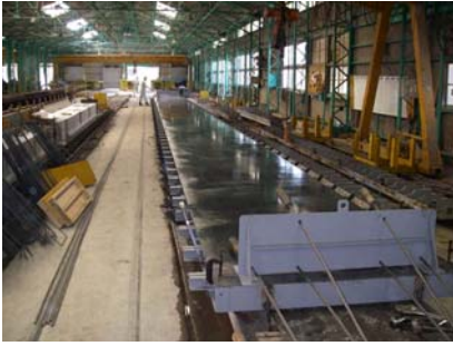
型枠清掃・剥離剤塗布
