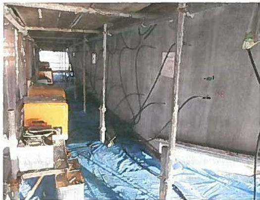
写真-1 施工状況
