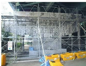
橋脚(はり部)のASR補修事例
