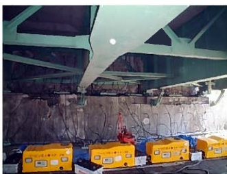
橋台のASR補修事例
