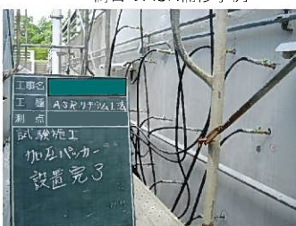
擁壁のASR補修事例
