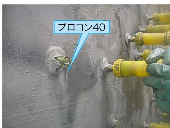
プロコン40先行注入の状況
