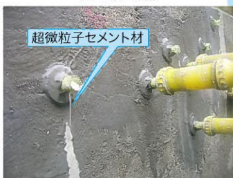
超微粒子セメント系注入材本注入の状況
