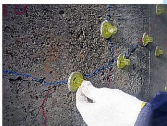
座金設置状況
