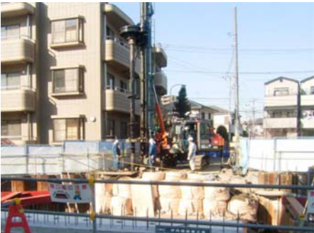
A2施工状況(正面)
