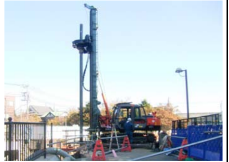
A1施工状況(側面)
