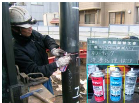
浸透探傷試験(洗浄液除去)
