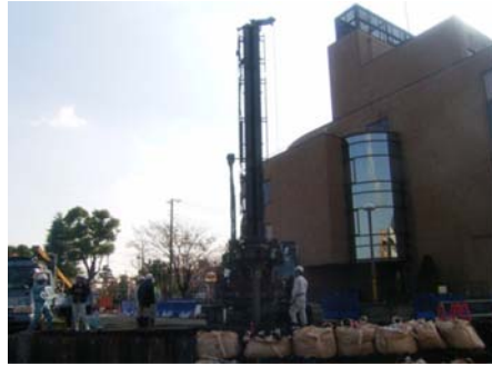
A1施工状況(正面)
