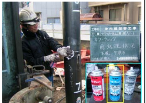
浸透探傷試験(前処理清掃)
