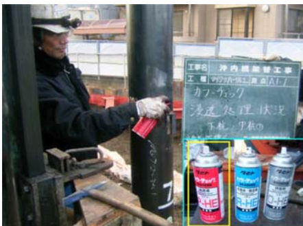
浸透探傷試験(浸透液塗布)
