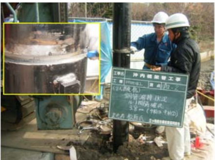
継手部ルート確認
