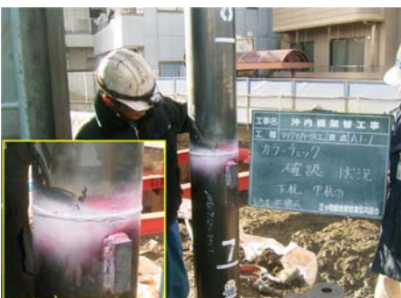
浸透探傷試験(目視確認)
