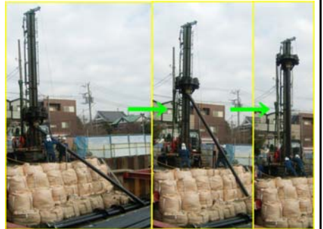
鋼管建込み状況
