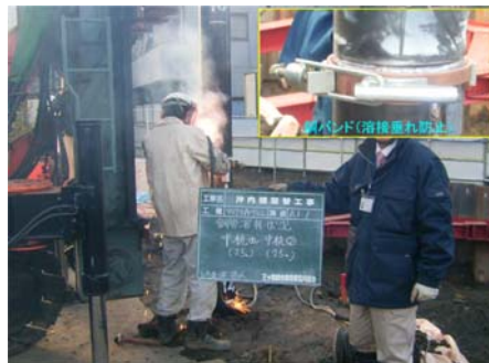
鋼管継手溶接状況
