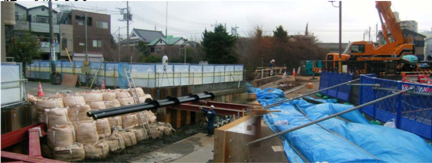
A2用鋼管搬入および鋼管仮置き(河川内)
