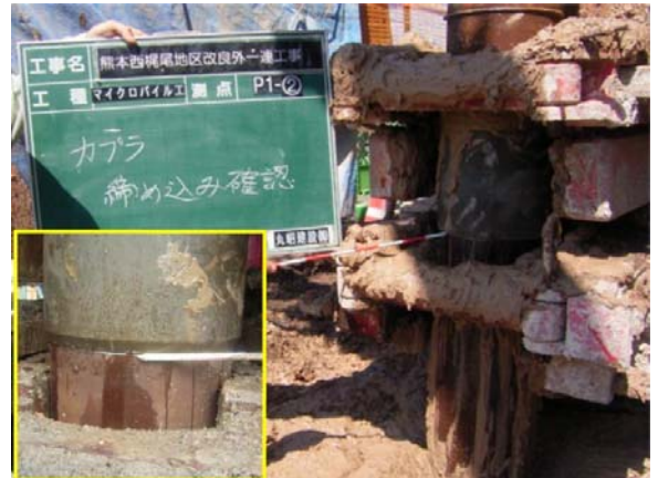
カプラ締め込み状況
