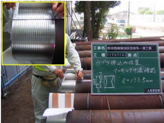
鋼管ネジ部マーキング状況
