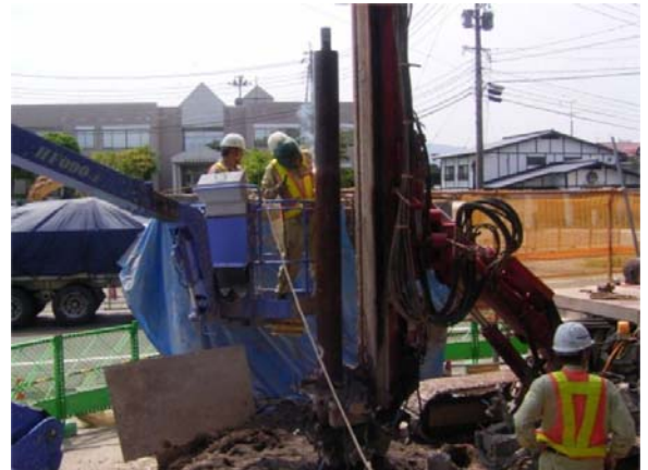
ヤットコ管溶接状況
