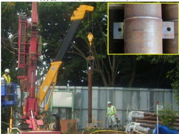
鋼管吊込み状況
