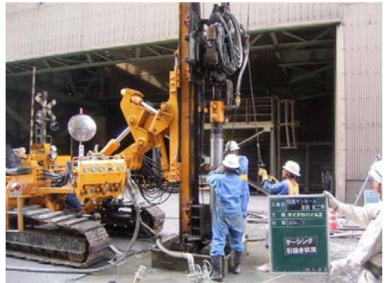
ケーシング引抜き状況
