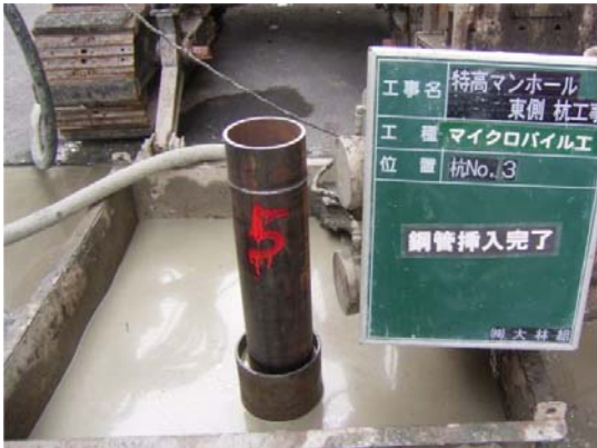
鋼管挿入完了
