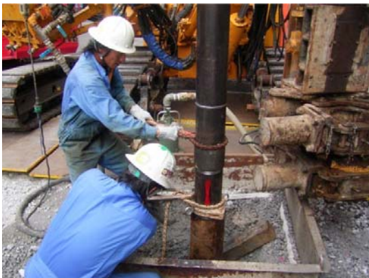
鋼管接続状況
