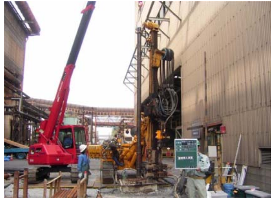
鋼管挿入状況
