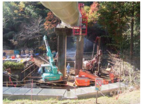
STマイクロパイル施工状況
