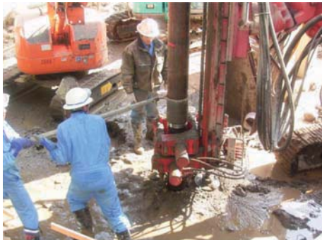
鋼管接続状況
