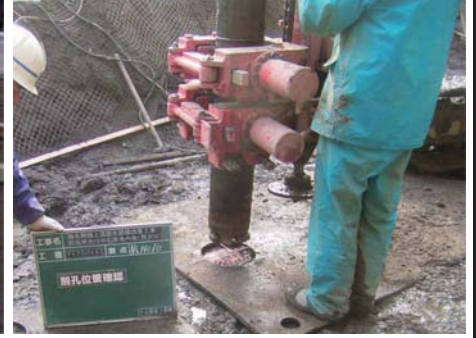
削孔位置確認
