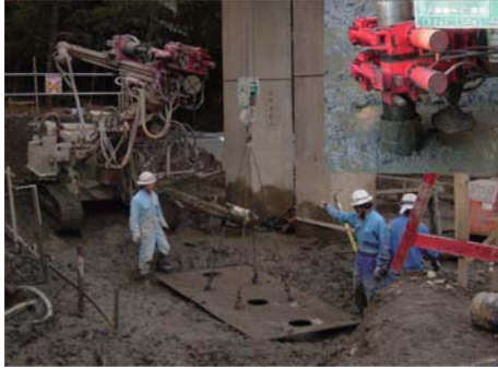
敷鉄板・ガイド管設置状況
