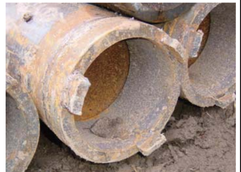
拡張ビット格納用突起加工
