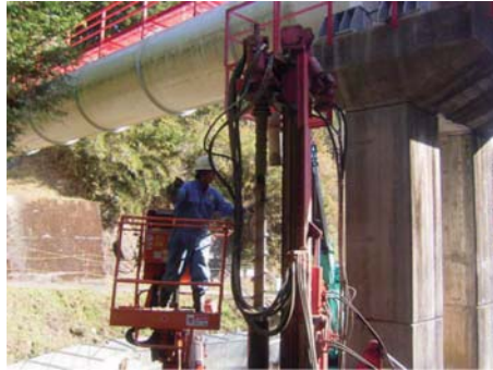
オーガ接続状況
