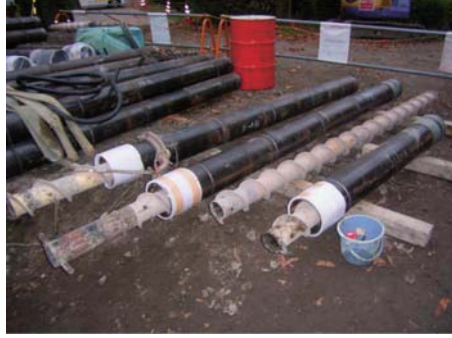
削孔準備(鋼管・オーガ)
