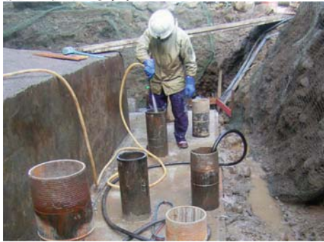
杭頭部清掃状況
