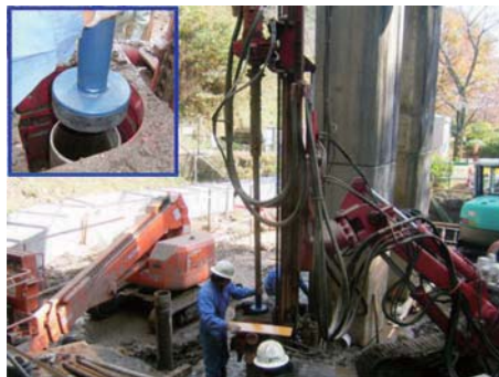
パッカー挿入状況
