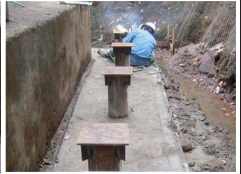
杭頭部材取付状況
