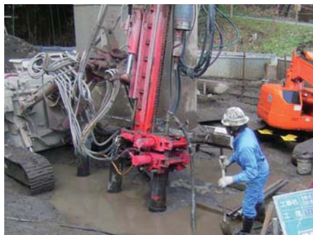
グラウト注入(段階加圧)
