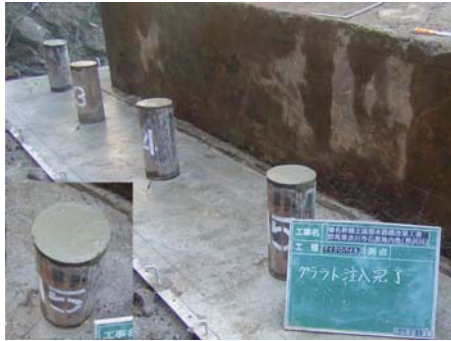
杭頭部グラウト充填完了
