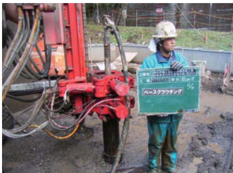
グラウト注入(ベースグラウチング)
