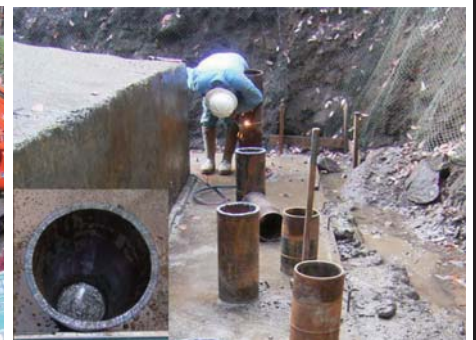
杭頭部鋼管切断状況
