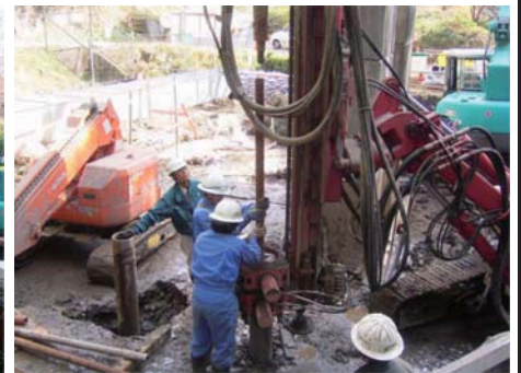
注入用ロッド接続状況
