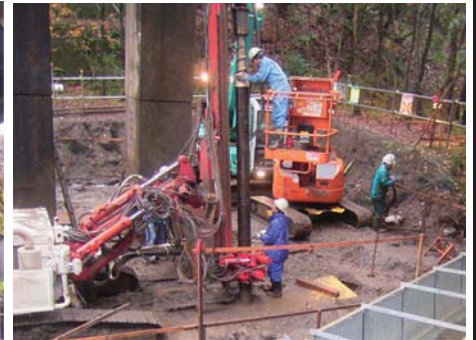
鋼管接続状況
