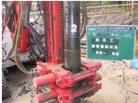
鋼管接続状況
