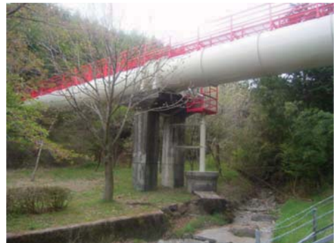
現場全景(着工前)
