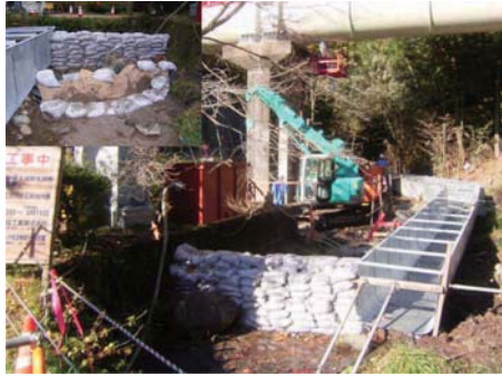
仮設(河川切替え・締切り)
