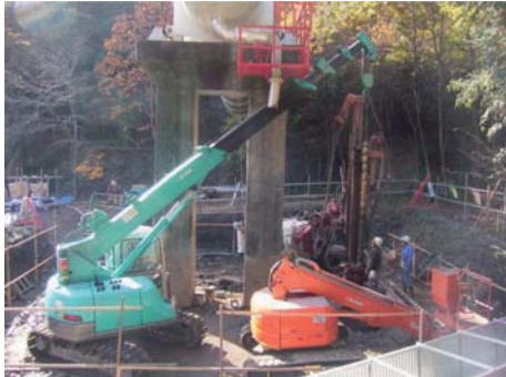
鋼管・オーガ吊り込み状況
