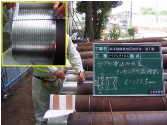
鋼管ネジ部マーキング状況
