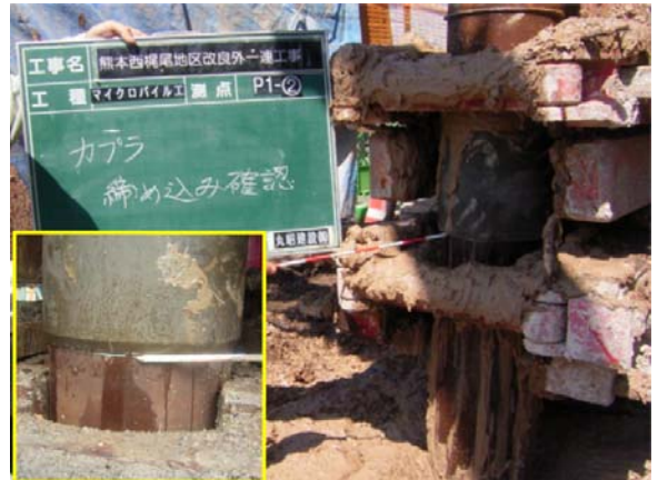
カプラ締め込み状況
