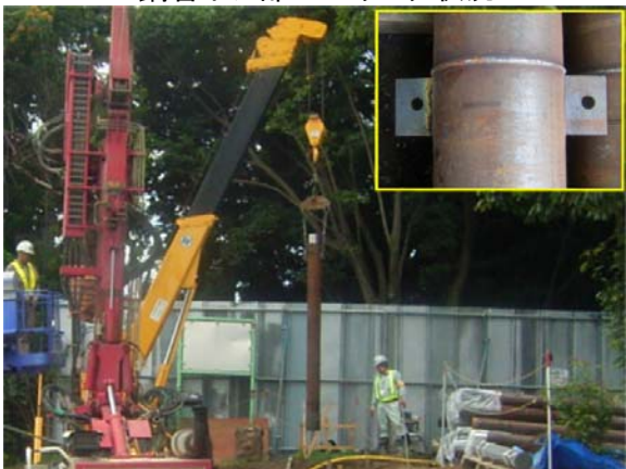
鋼管吊込み状況
