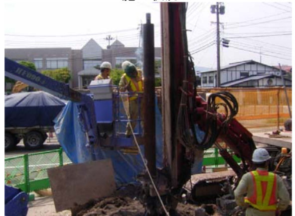
ヤットコ管溶接状況
