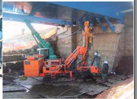
施工状況(A2橋台)
