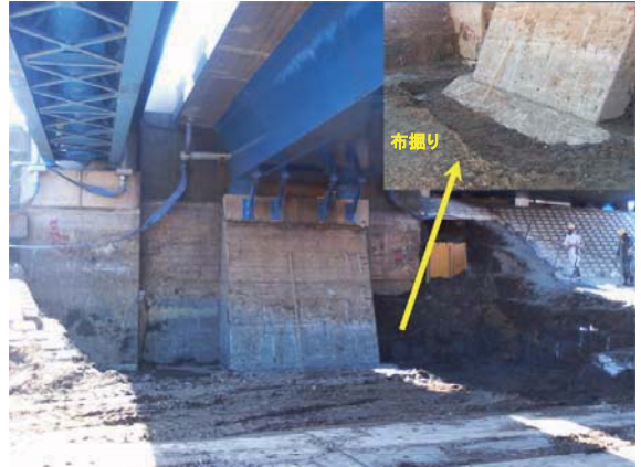
着工前(A2橋台)
