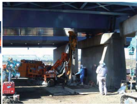
施工状況(P4橋脚)
