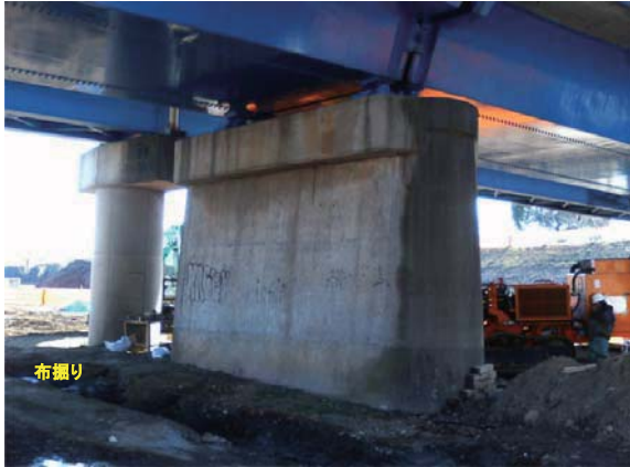
着工前(P4橋脚)
