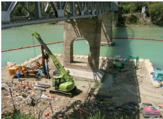
施工状況全景
