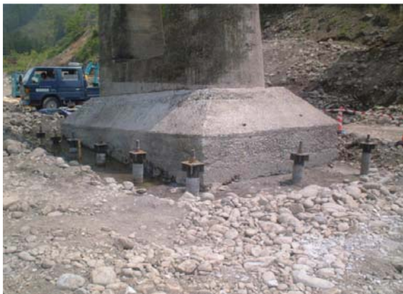
完成全景(上流→下流)
