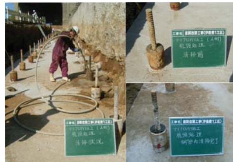
杭頭部清掃(コンプレッサー使用)
