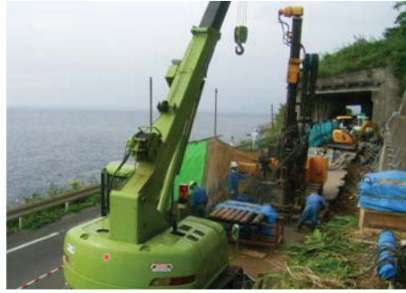
施工状況(山側)
