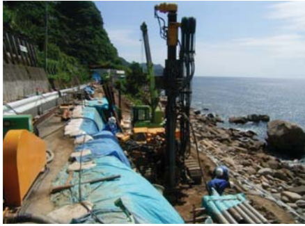
施工状況(海側)
