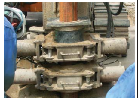
削孔スライム飛散防止対策
