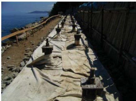
完成全景(海側)
