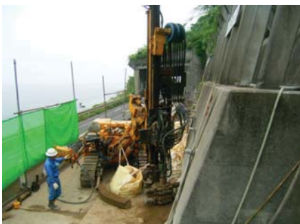
ダウンザホールハンマ先行削孔状況
