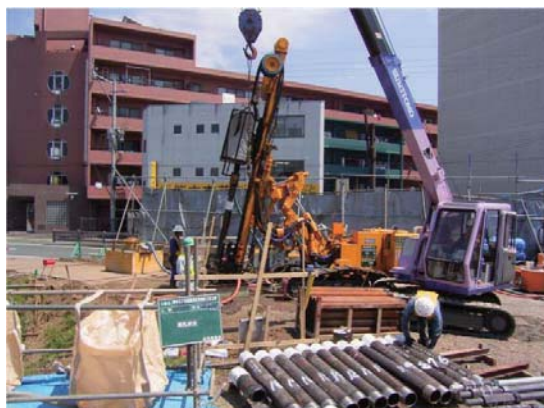
A2橋台施工状況
