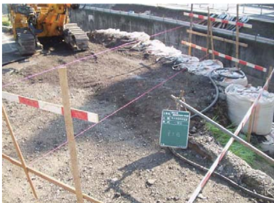
A1橋台着工前全景
