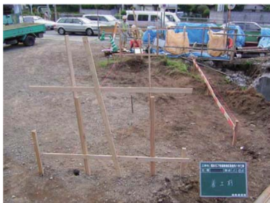
A2橋台着工前全景
