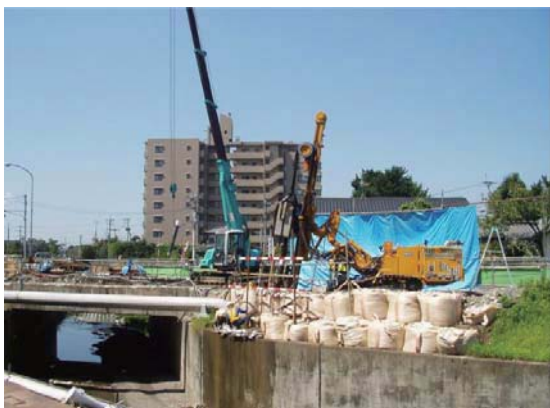
A1橋台施工状況
