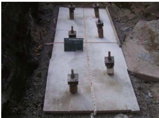
A2橋台完成時全景
