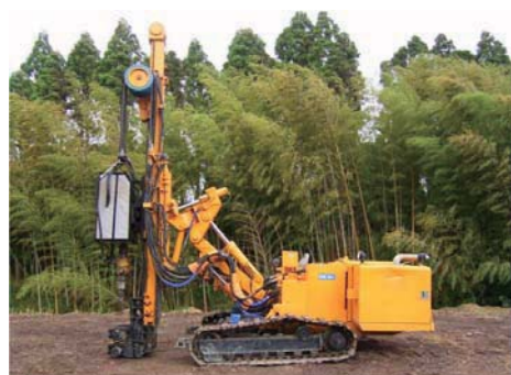
削孔機(ハンマー部防音シート養生)
