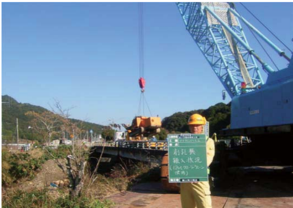
削孔機搬入状況(120t吊クレーン)
