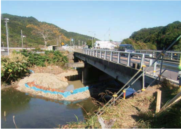
現場全景(上流側A2→A1)
