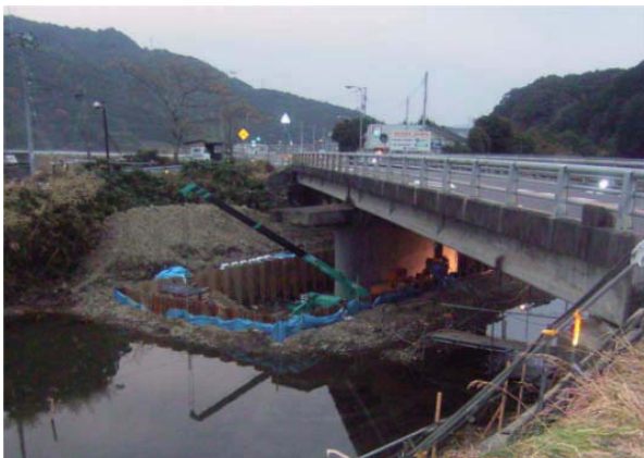
施工状況(現場全景)
