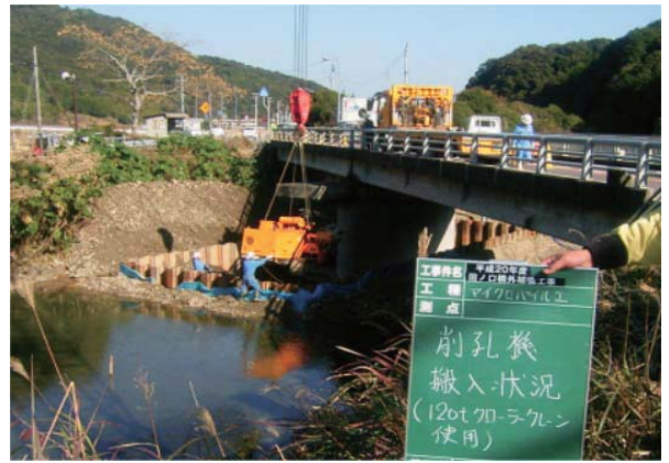
削孔機搬入状況
