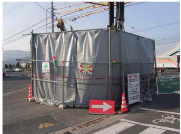
防音&泥水等飛散防止フェンス
