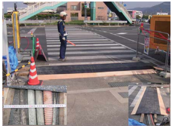
横断歩道部のホースライン養生
