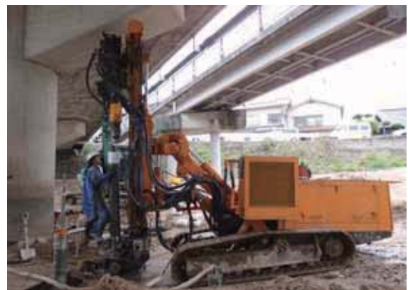
施工状況 (中央車道橋P2)
