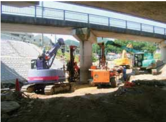
施工状況 (上流歩道橋P2)
