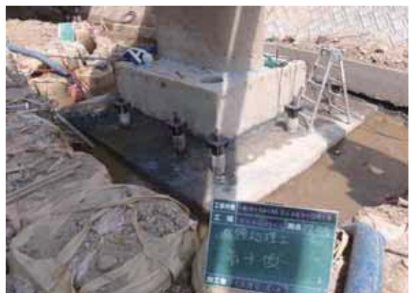
施工完了 (上流歩道橋P2)
