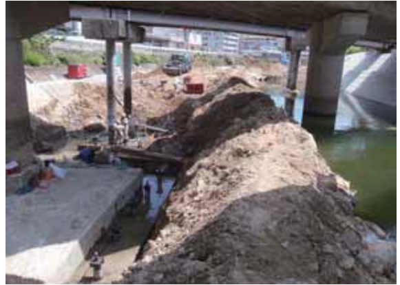
河川縮切状況
