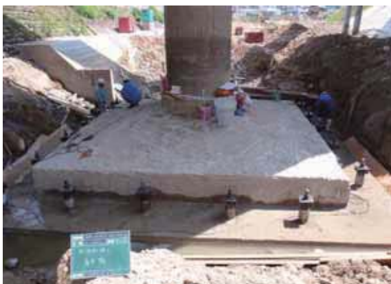
施工完了 (中央車道橋P1)
