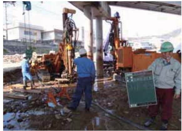
施工状況 (下流歩道橋P2)
