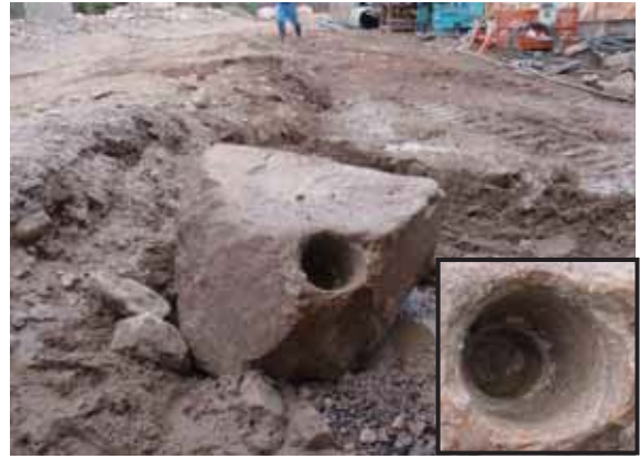
削孔途中で回収撤去した転石
