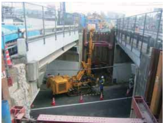
A1施工状況
