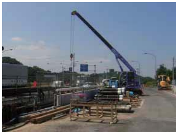
橋面上からの材料吊り下ろし状況
