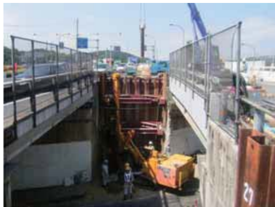
A2施工状況
