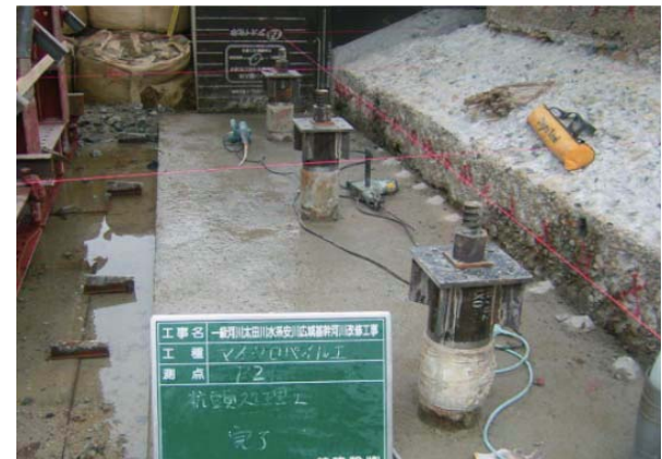
杭頭処理完了
