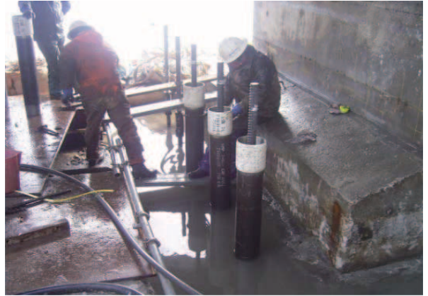
最上部鋼管接続状況
