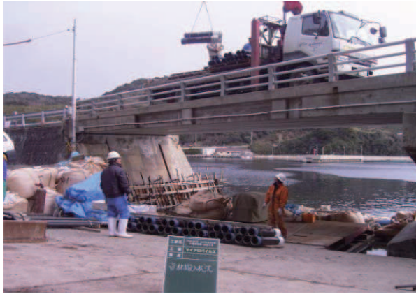
資材搬入状況
