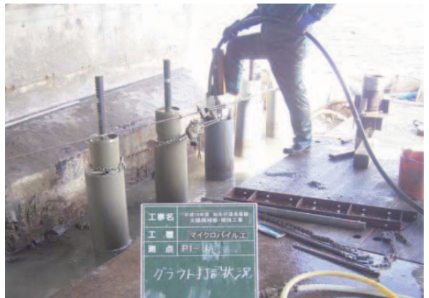
グラウト充填状況
