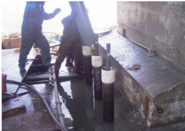
防護塩ビ管配置状況
