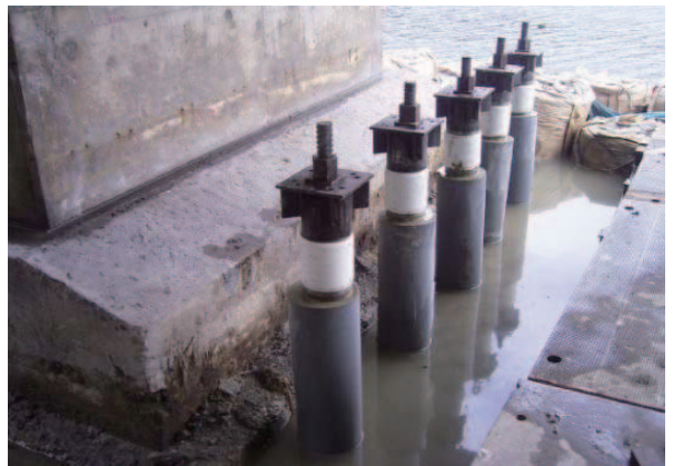
杭頭処理完了
