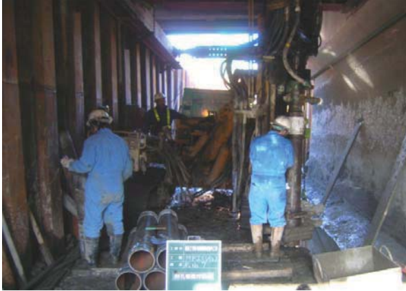
削孔機据付状況
