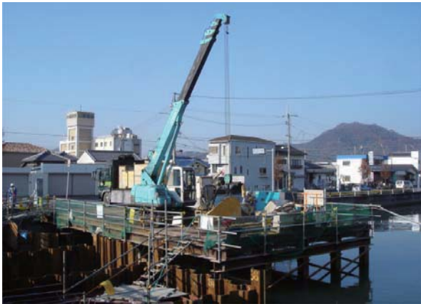
仮設構台全景
