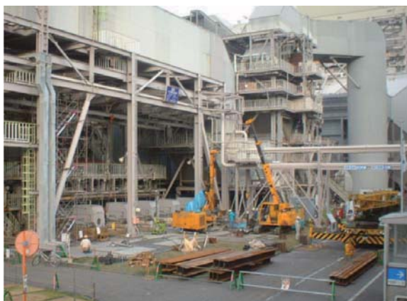
HMP施工状況
