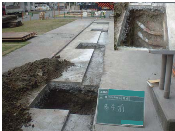
着工前全景(埋設ケーブル)
