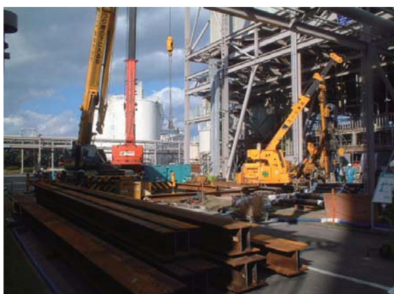
HMP & H鋼杭施工状況
