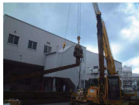
H鋼杭施工状況(バイブロハンマー)
