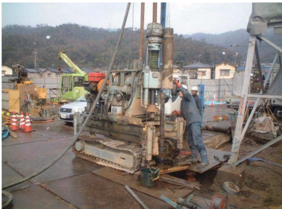
ダウンザホールハンマ施工状況
