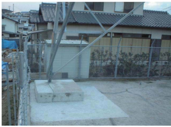
新設フーチング完成
