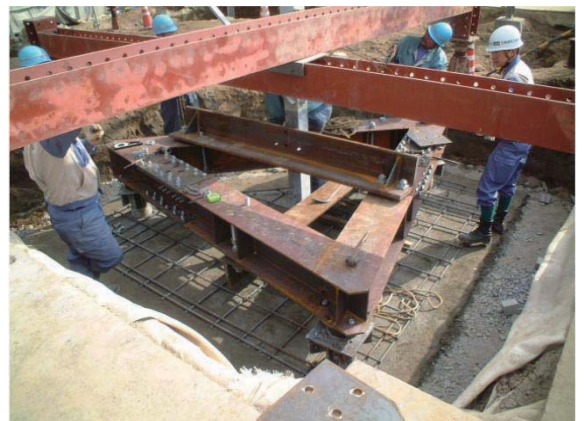
HMP杭と鉄塔脚の結合部
