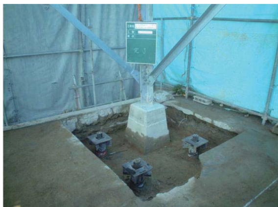
HMP打設完了
