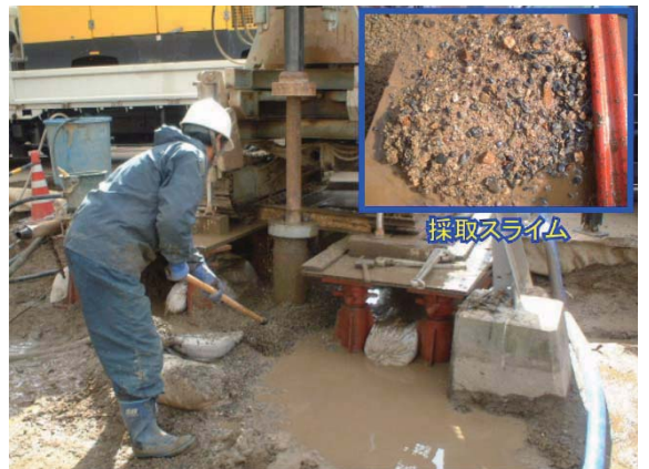
ダウンザホールハンマ施工状況 (採取スライム)
