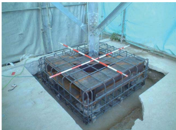
新設フーチング補強
