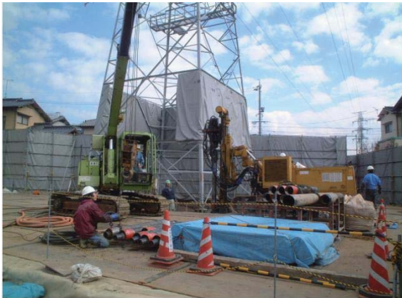
HMP施工状況
