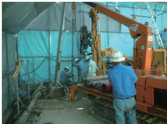
芯鉄筋挿入状況
