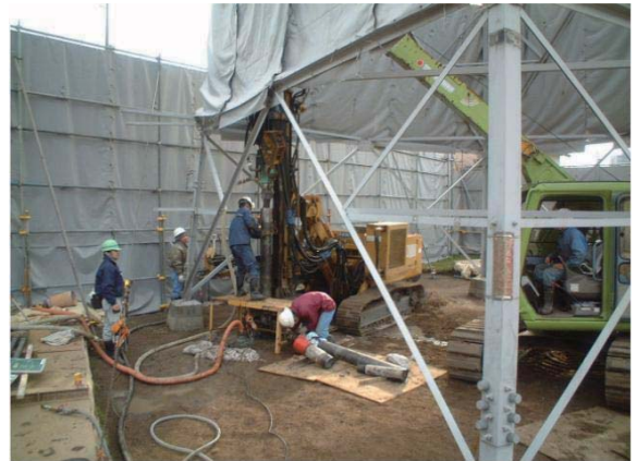
HMP施工状況
