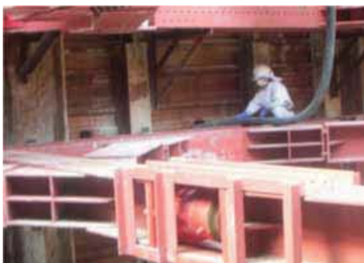
横矢板背面グラウト打設状況
