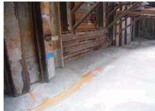
横矢板下部コンクリート打設
