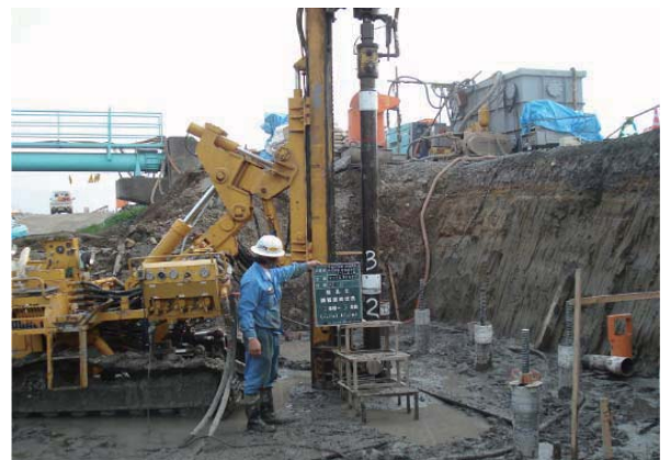
鋼管接続状況
