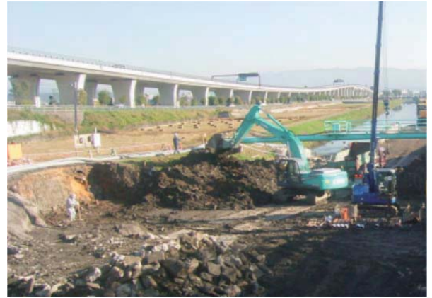
基面整地状況
