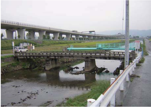
工事着手前全景
