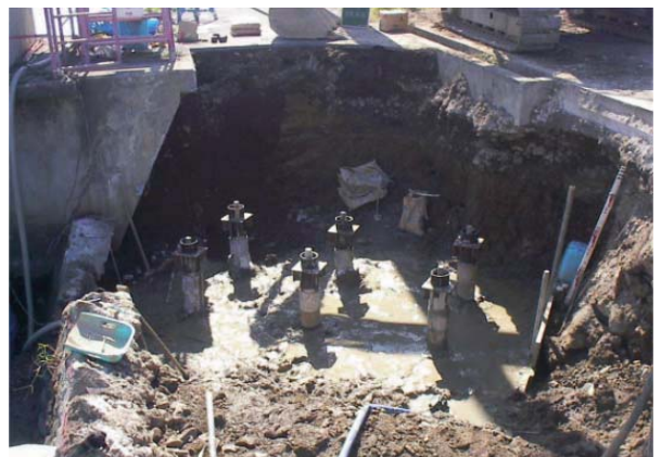
A2杭頭処理完了
