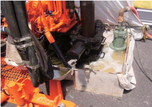
泥水等流出防止対策
