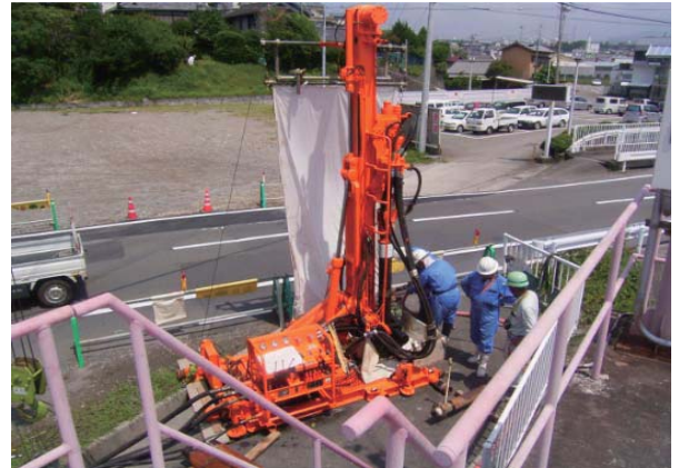
A2施工状況
