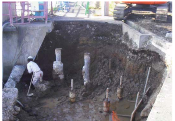
A2掘削状況
