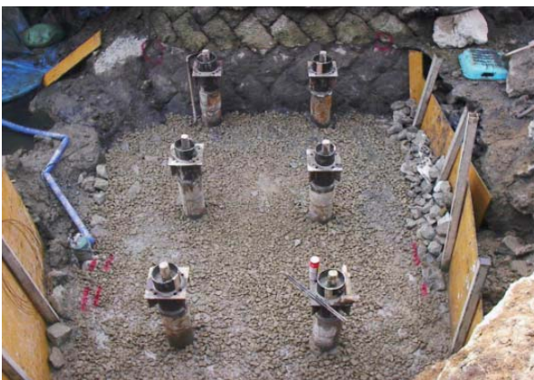
A1杭頭処理完了
