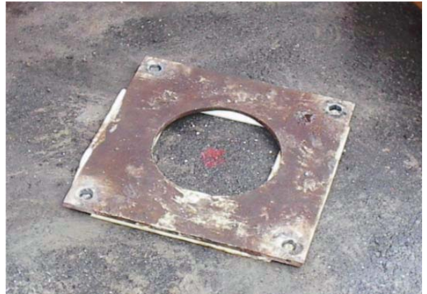
ずれ止め鉄板
