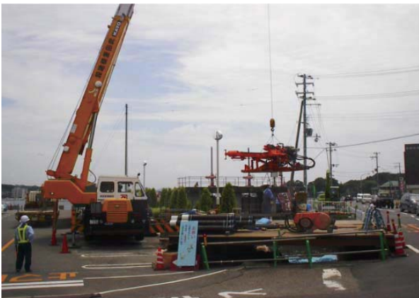
削孔機吊込み状況(A1)
