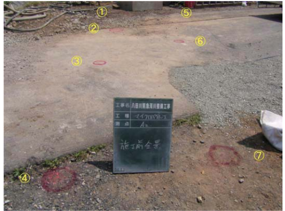
着工前(杭位置)
