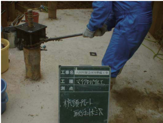
杭頭鋼管取付
