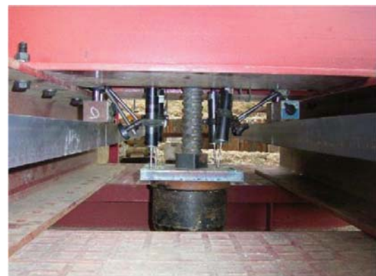
変位計設置状況
