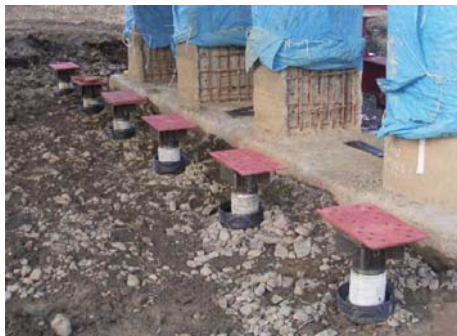
杭頭処理完了
