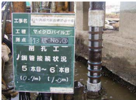
杭頭定着鋼管(せん断リング方式)
