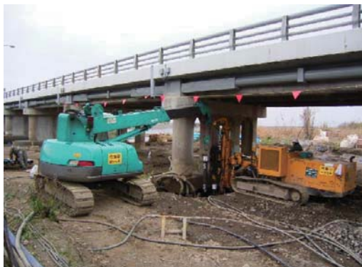
マイクロパイル施工状況
