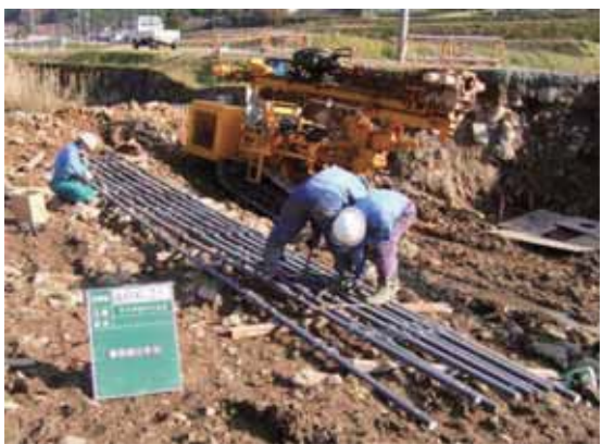
鉄筋組立状況
