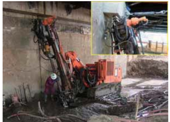
A1施工状況
