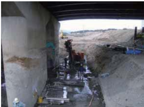
P1施工状況
