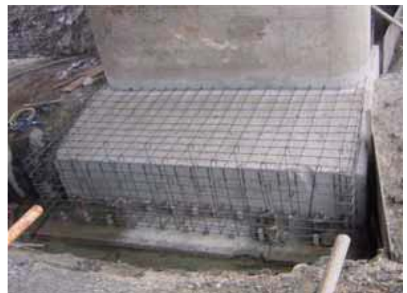
P1完成全景(上り側)
