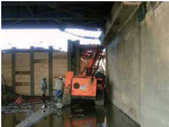
A1施工状況
