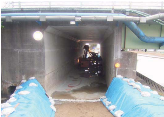
ボーリングマシン配置状況
