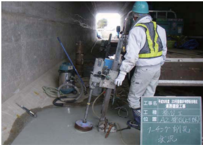
底版コア穿孔状況
