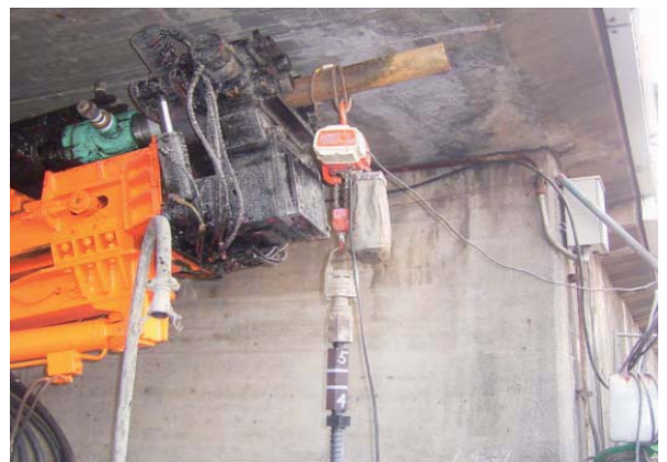
電動チェーンブロックによる鉄筋吊込み状況
