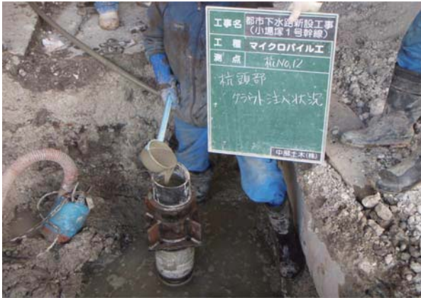
グラウト充填状況
