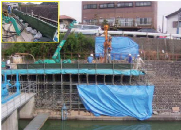
削孔状況および飛散養生
