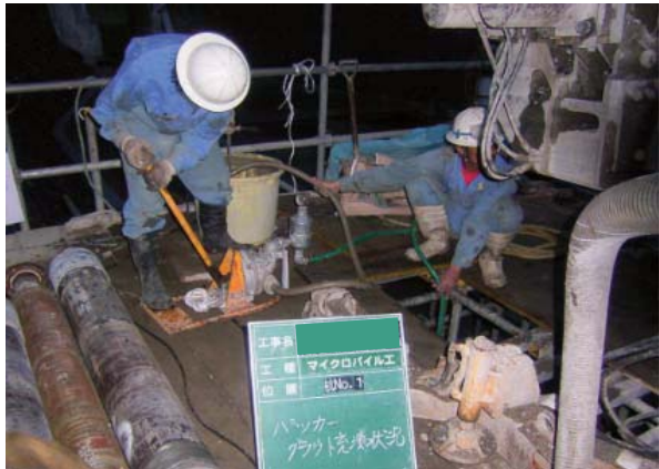
パッカー内グラウト充填状況
