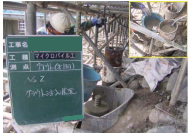
鋼管内グラウト注入状況
