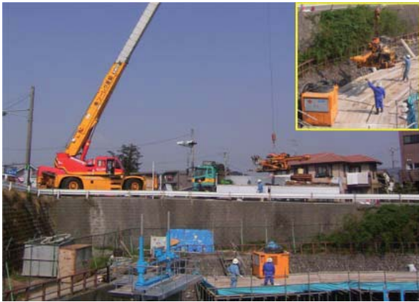
削孔機吊込み状況
