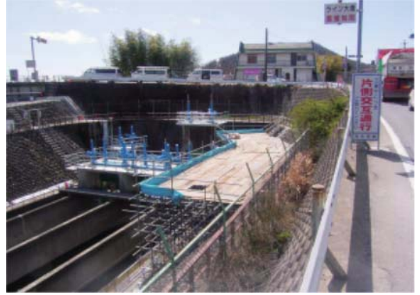
現場全景(上流→下流)
