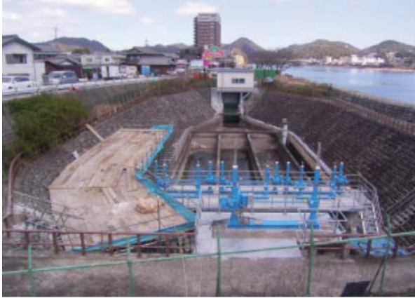
現場全景(下流→上流)
