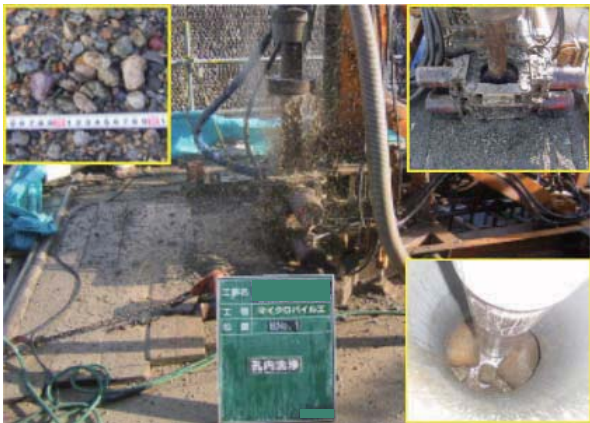
孔内洗浄およびスライム排出状況
