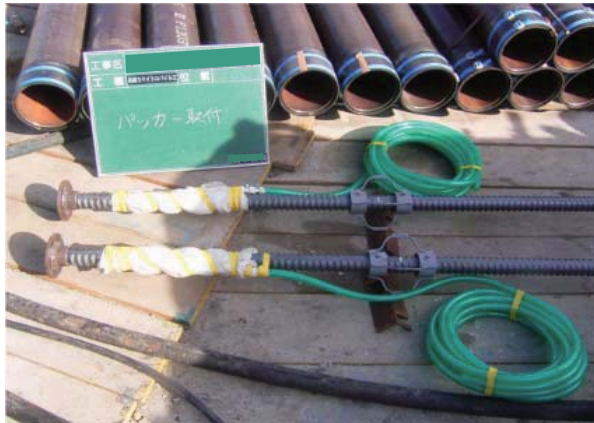
パッカー仮固定完了
