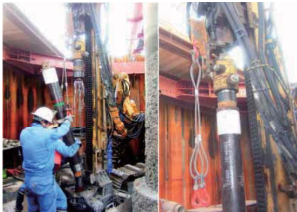
鋼管吊込み状況
