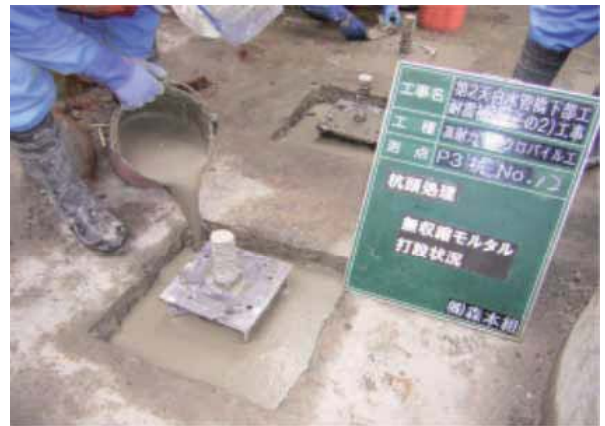
無収縮モルタル打設状況
