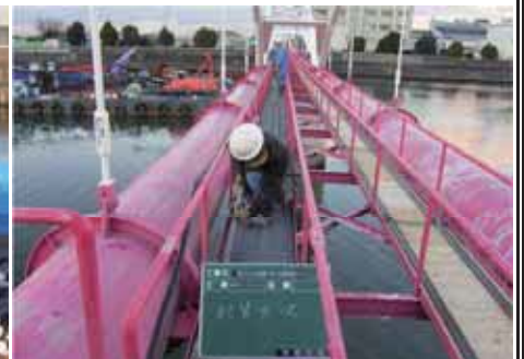
配管組立状況(点検通路上)
