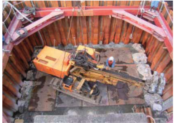
削孔機 締切内吊込み状況
