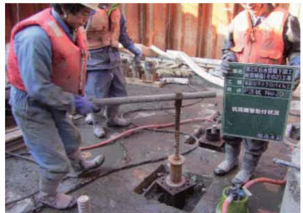
杭頭鋼管取付状況
