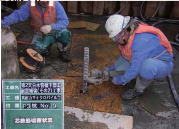
鉄筋予長切断状況
