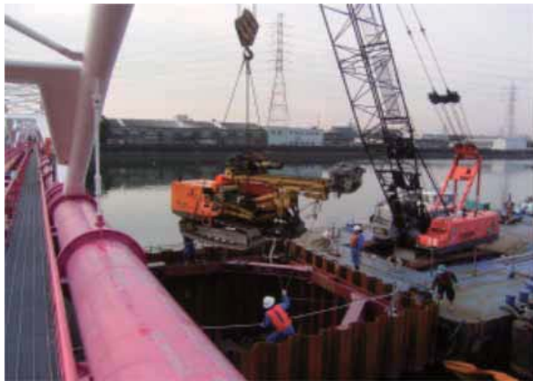
削孔機 締切内吊込み状況
