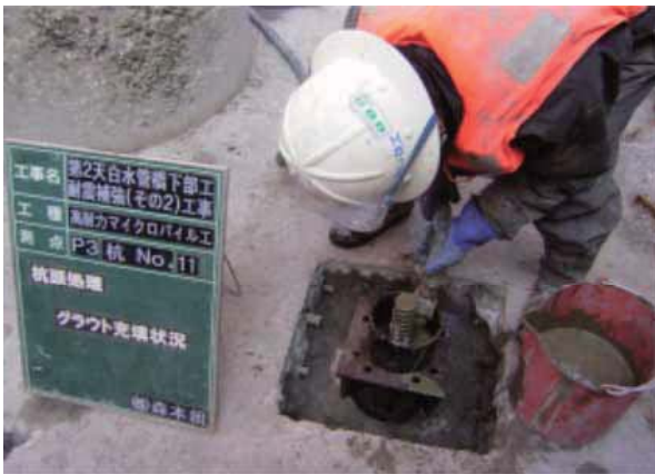
グラウト充填状況
