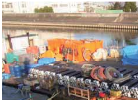
泥水プラント(P3台船上)
