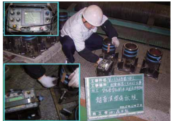
杭頭溶接部 超音波探傷試験
