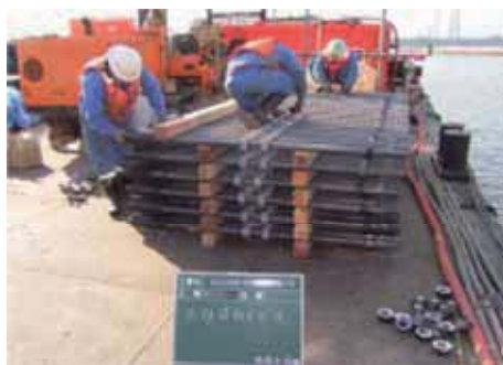
鉄筋地組状況
