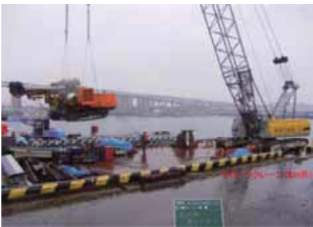
資機材積み込み状況(金城ふ頭)
