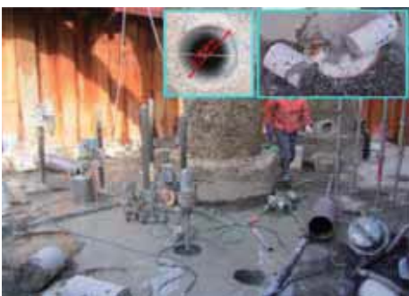
既設フーチング コア穿孔状況
