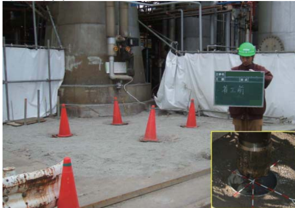
着工前全景(ガイド管)
